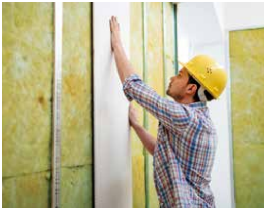
Verlegung von Gipskartonplatten mit FIBRANGyps.
