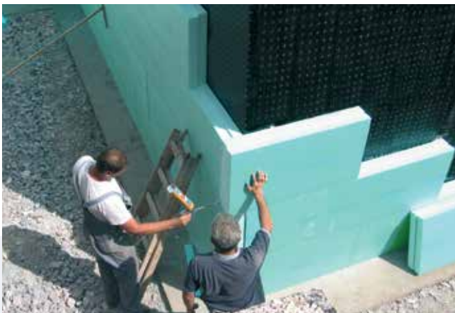
Gekreuztes Anbringen der FIBRANxps 300-L Platten und das Anpassen der Verbindungen.
