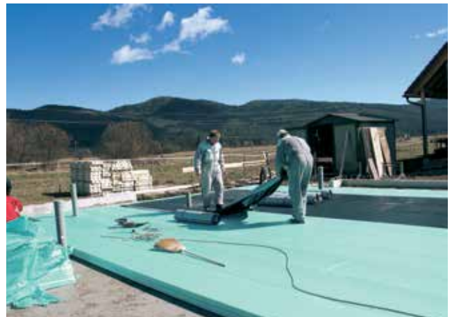
Selbstklebende Abdichtung zwischen zwei Dämmschichten FIBRANxps.
