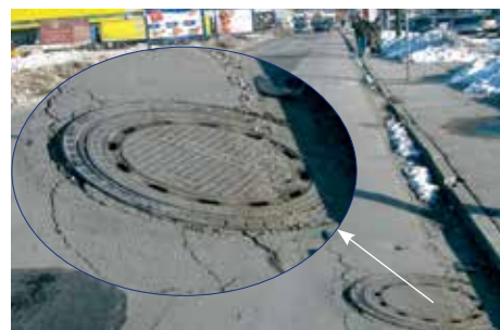
Das Frieren von Moorböden, die mit Wasser durchtränkt sind, verursacht Strassen- und Kanalisationschäden.
