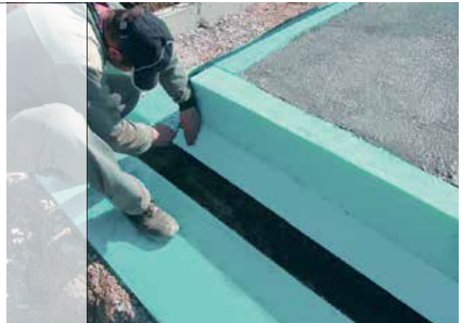
Detail 9 – Abdichtung zwischen zwei Dämmschichten FIBRANxps 300-L oder 500-L. Das Anbringen von einer dreieckigen Leiste, mit der man vertikale bituminöse Frakturen der Abdichtung mindert.
