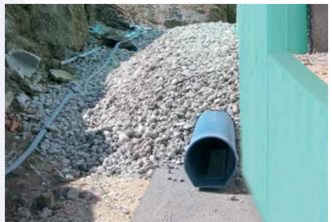
Um ein wärmedämmtes Objekt empfiehlt es sich eine Drainage zu legen, um die Abwässer abzuleiten, was eine bessere Wärmedämmung ermöglicht.
