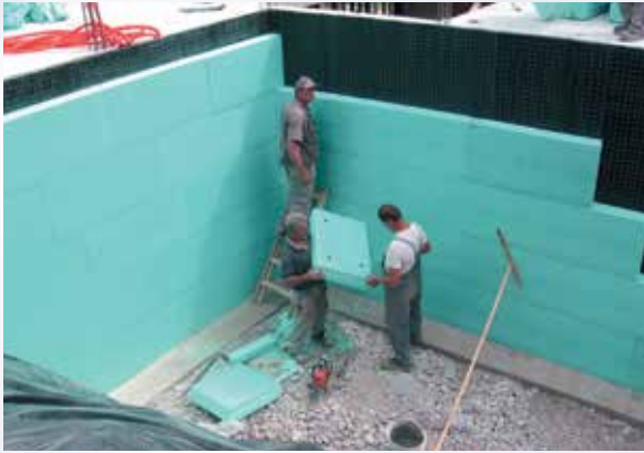
Das Kleben von FIBRANxps 300-L Platten mit den Pads FIBRANsticks.
