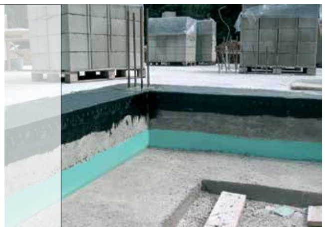
Detail 10 – Eine bituminöse Abdichtung auf der Gründungsplatte eines unterkellerten Objektes. Die Wärmedämmung FIBRANxps 300-L oder 500-L unter der Gründungsplatte.
