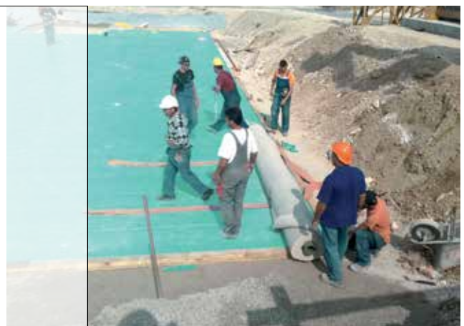
Detail 8 – Ökologische Tonabdichtung verlegt auf FIBRANxps 300-L oder 500-L vor dem Betonieren der Gründungsplatte eines Schulobjektes.
