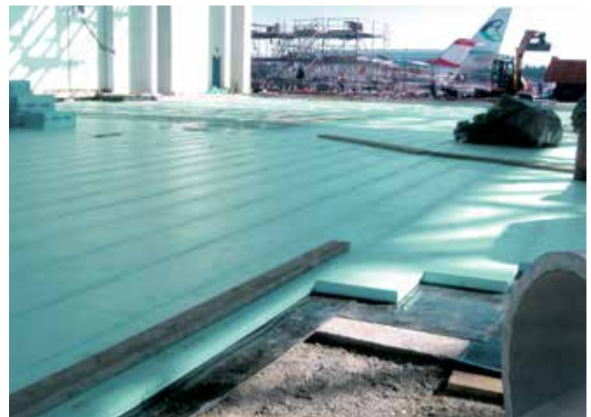
Bodenwärmeschutz in einer Flughalle mit FIBRANxps 700-L.
