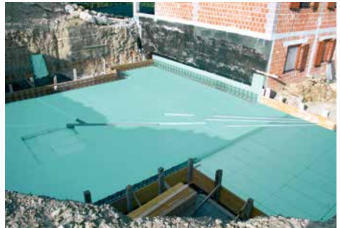
Das Anbringen der Installationen in die Wärmedämmschicht FIBRANxps in vorgefertigte Nuten.
