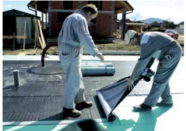
Belegen selbstklebender Abdichtung auf die Wärmedämmungsplatten FIBRANxps 300-L oder 500-L
