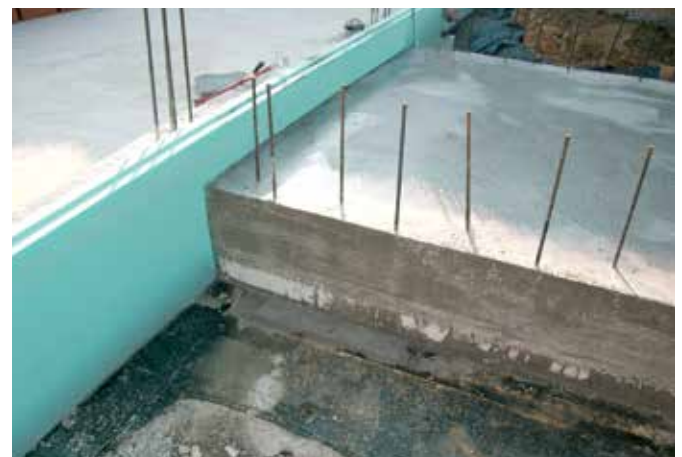
Detail 3 – Das Anbringen der Montageelemente erfolgt nach Anweisungen des Herstellers. Vorsichtig dichten wir die Stellen ab, die wir durch das Verbinden verursacht haben und isolieren dann den Teil des Gebäudes mit der kalten Konstruktion des Lichtschachtes.
