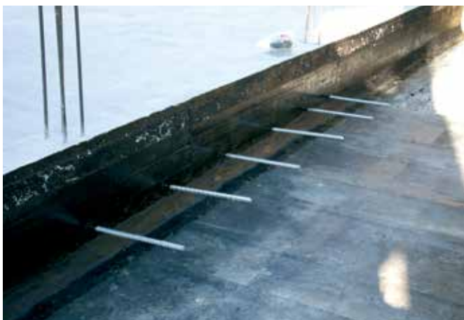
Detail 3 – Das Anbringen der Montageelemente erfolgt nach Anweisungen des Herstellers. Vorsichtig dichten wir die Stellen ab, die wir durch das Verbinden verursacht haben und isolieren dann den Teil des Gebäudes mit der kalten Konstruktion des Lichtschachtes.
