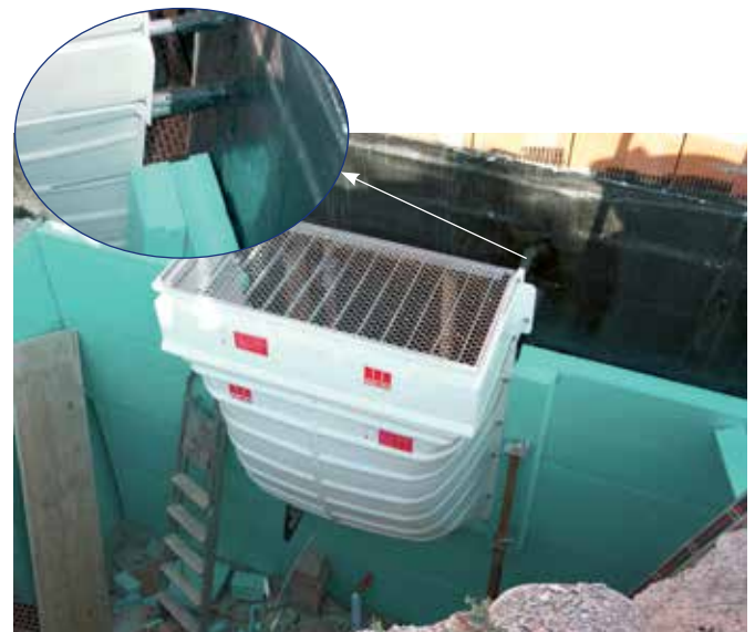
Detail 3 – Das Anbringen der Montageelemente erfolgt nach Anweisungen des Herstellers. Vorsichtig dichten wir die Stellen ab, die wir durch das Verbinden verursacht haben und isolieren dann den Teil des Gebäudes mit der kalten Konstruktion des Lichtschachtes.
