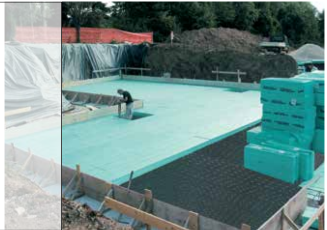
Detail 7 – Aufgrund der Verteilungslast entscheidet man sich für Stufenbau, wie es im Detail zu sehen ist. Vorbereitung des Wärmedämmungsuntergrundes eines Wohnobjektes.
